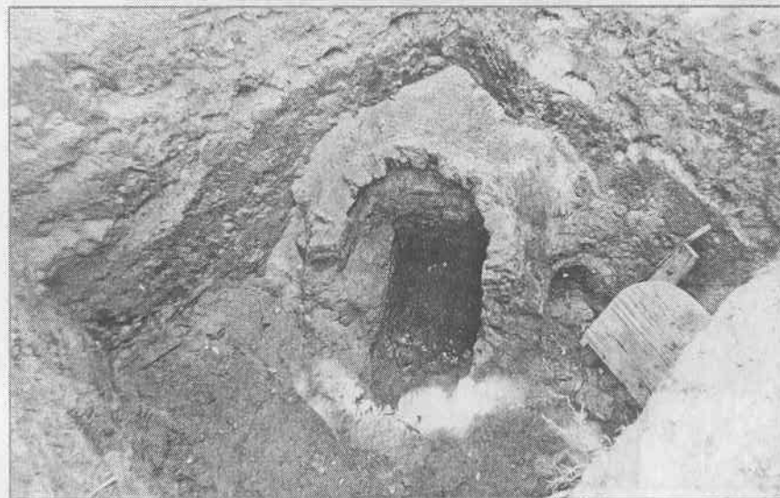
Вход в подземелья Вала
